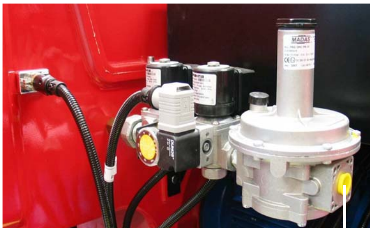
подсоединение к сети распределения газа
