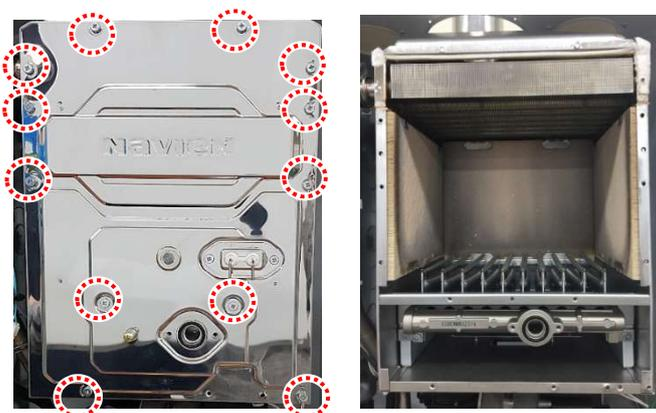
⑤ Выкрутите 2 винта коллектора с форсунками и замените на коллектор с форсунками нужного размера.
