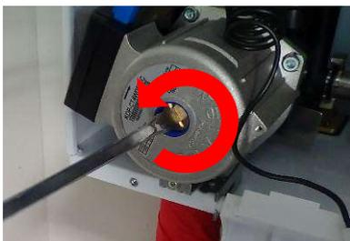
② Измените режим работы контроллера на «ввод в эксплуатацию» и после этого при помощи плоской отвертки принудительно поверните ось.
