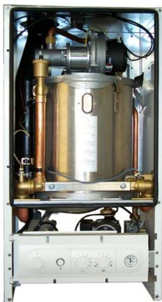
С закрытой камерой сгорания предназначены для эксплуатации с подачей воздуха для горения как из атмосферы, так из помещения.
